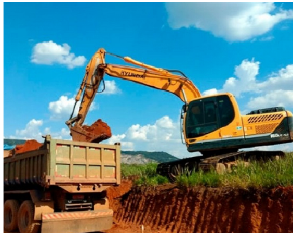
Escavação, carga e transporte de material 3ª cat Est. 61985, Km 406
